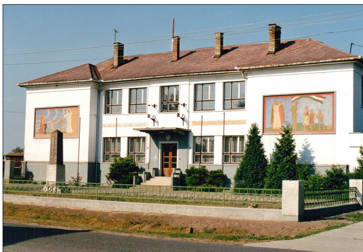
5. kép. A csávolyi általános iskola
